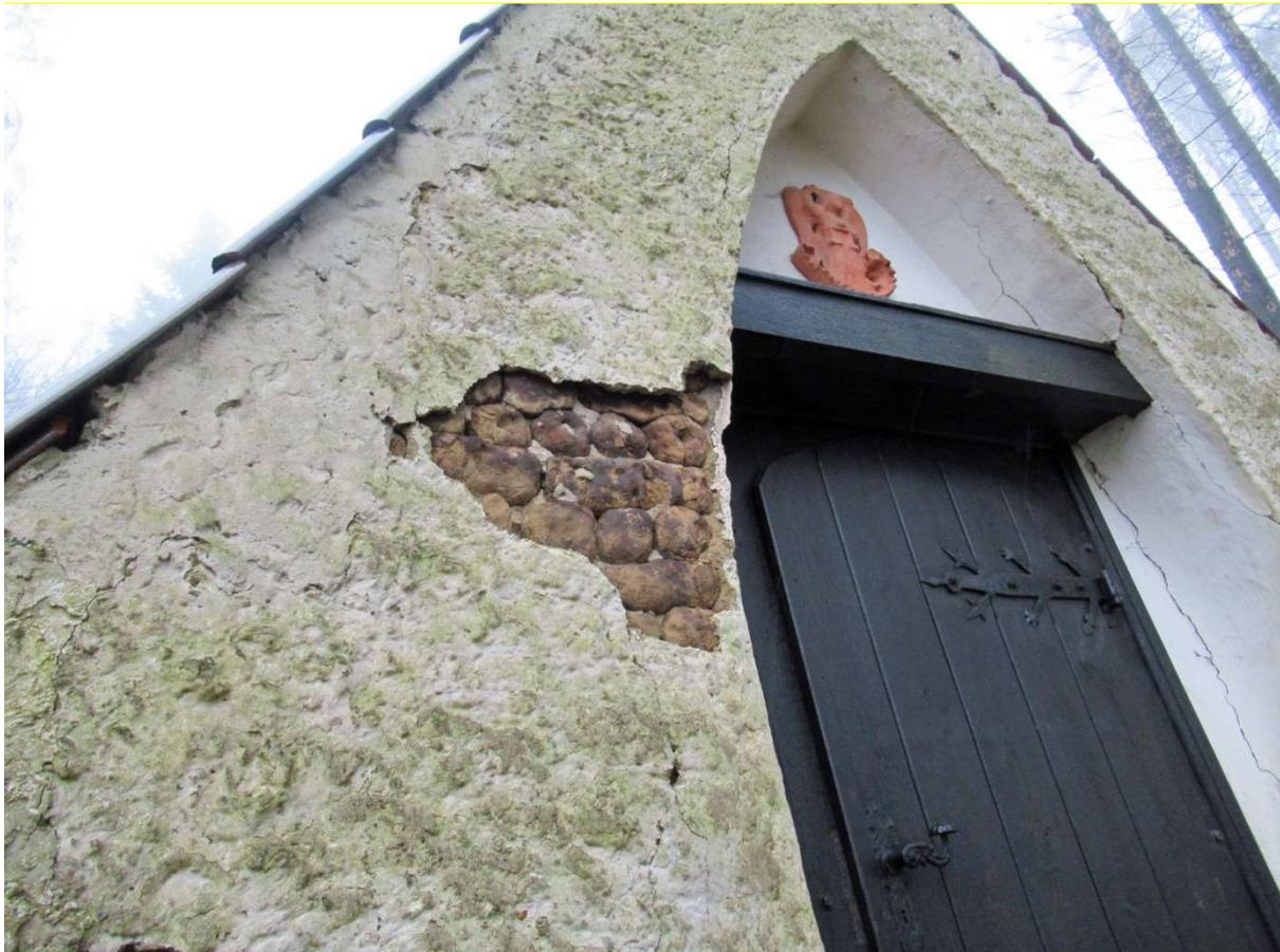
**Abb. 26,** Nach dem Abfall von Teilen des Zementputzes der Grabkapelle sind die ungebrannten Lehmbröte der Witterung ausgesetzt. Das Bauwerk steht bisher nicht unter Denkmalschutz (Stand März 2021).
